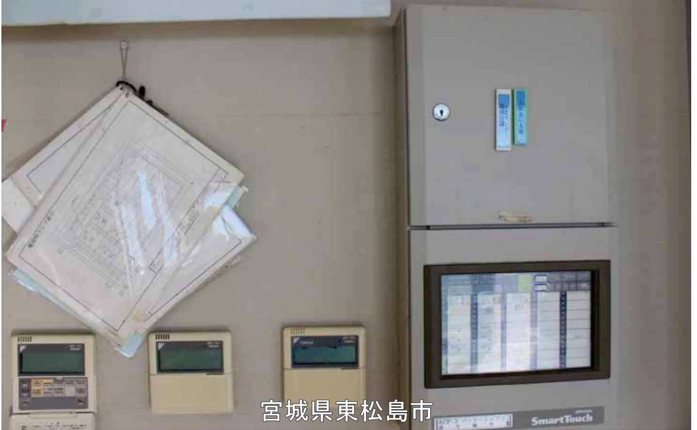
0901_5_024_020734_大曲市民センター_2012.11.27_大曲市民センター改修工事前
