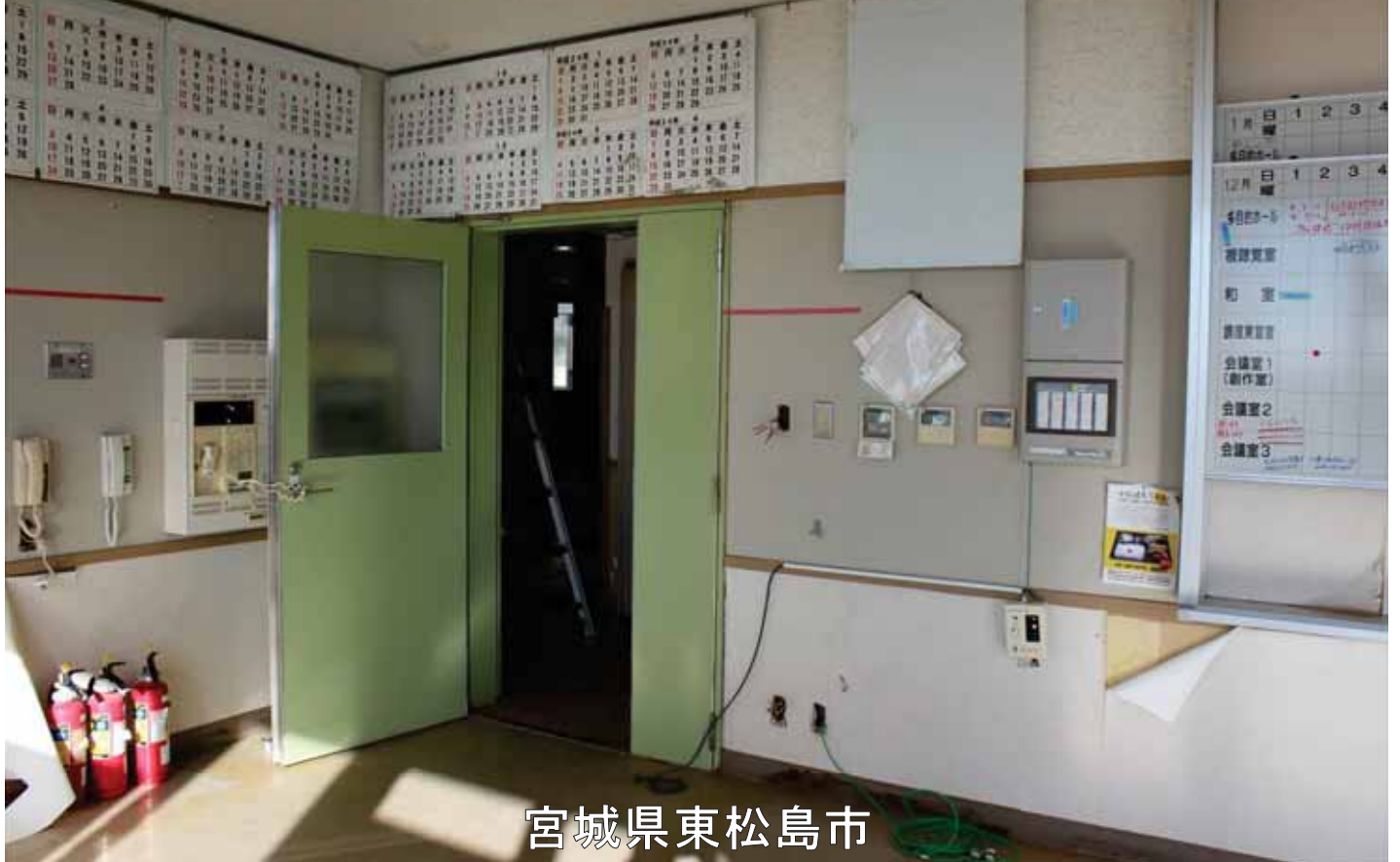
0901_5_024_020673_大曲市民センター_2012.11.27_大曲市民センター改修工事前
