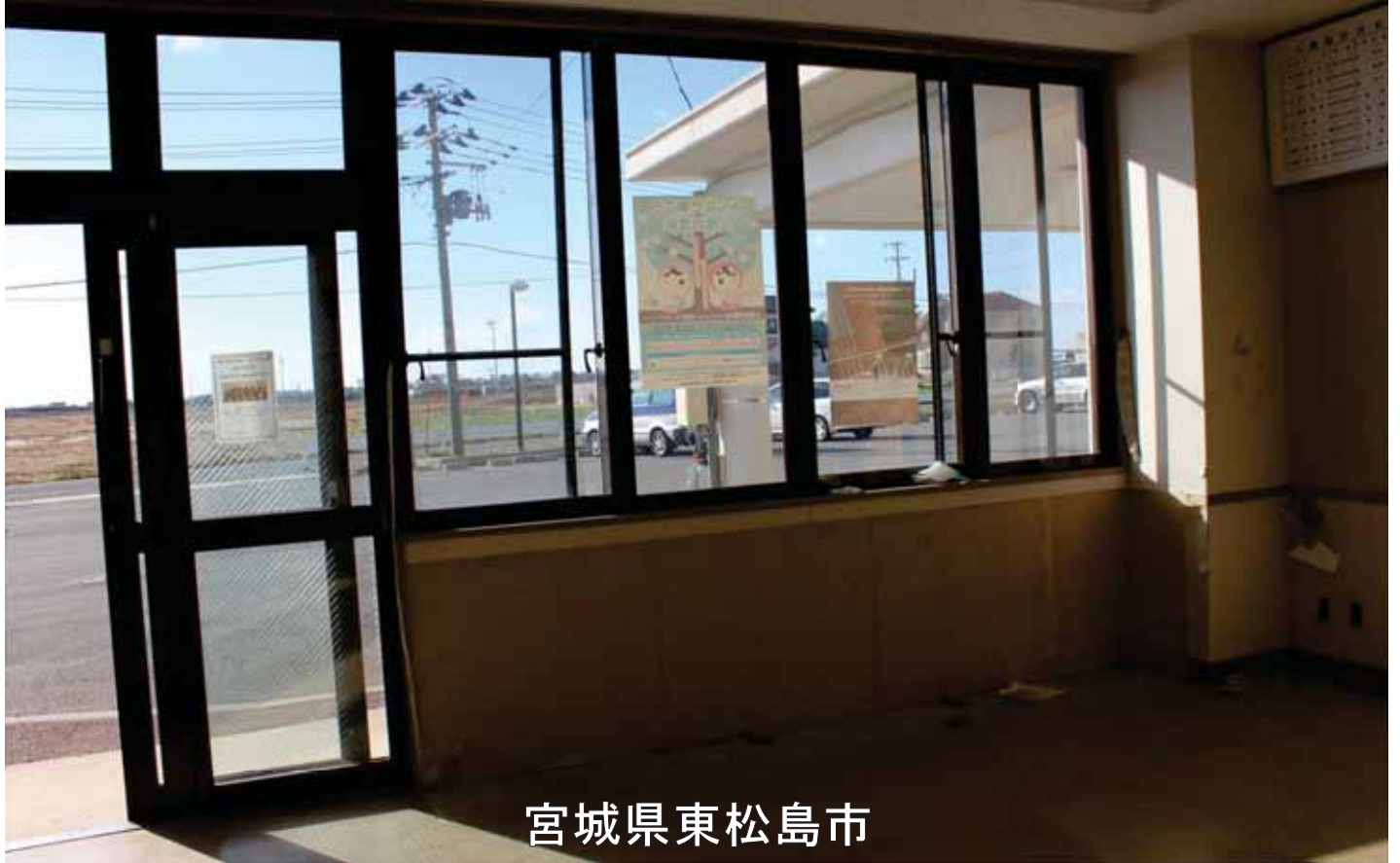
0901_5_024_020672_大曲市民センター_2012.11.27_大曲市民センター改修工事前
